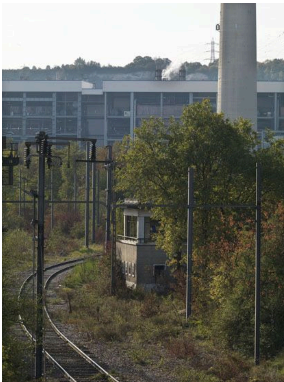
Porcheville : centrale électrique vue depuis la D 146.
