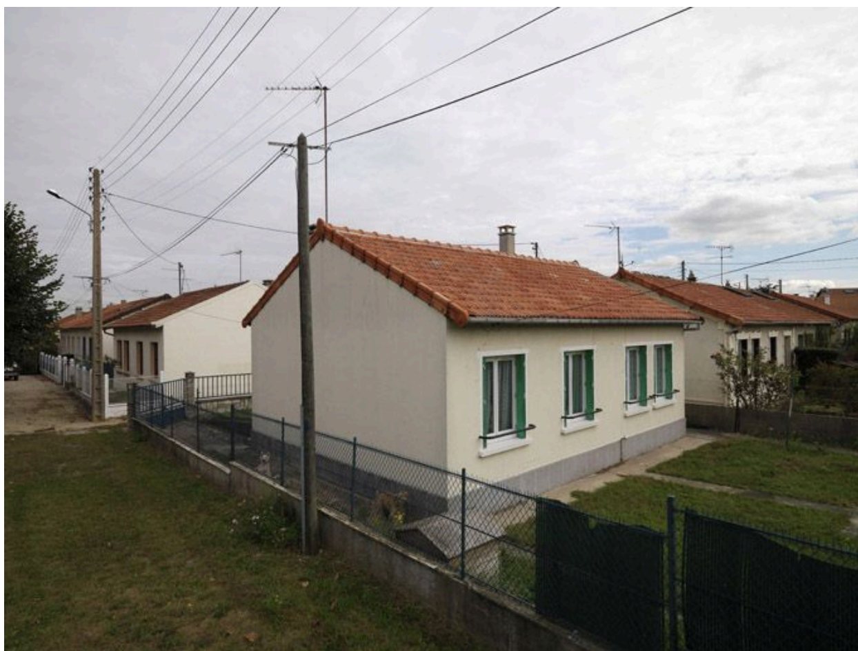
Pavillons en rez-de-chaussée, rue des Castors (au premier plan, n° 41).
