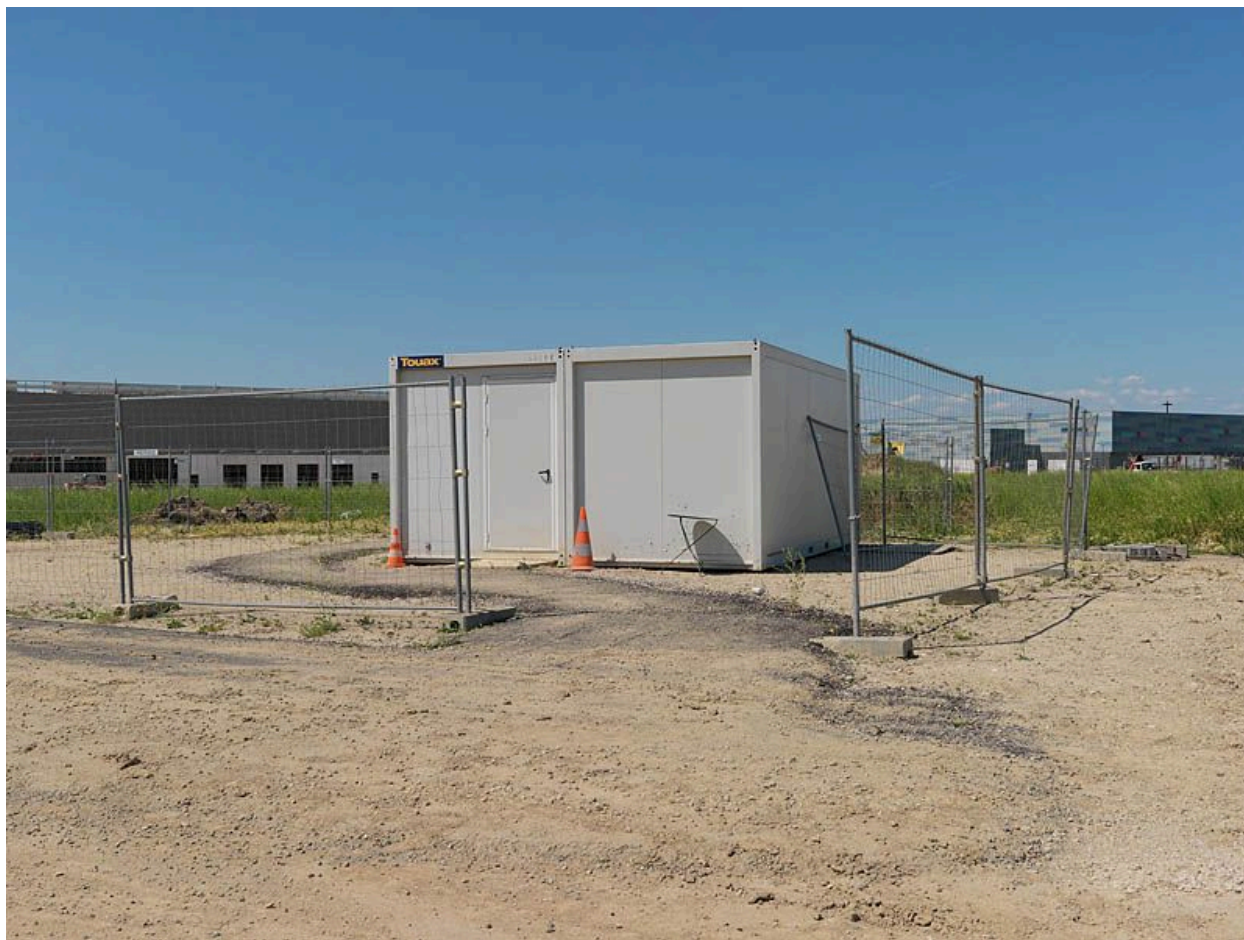
95, Gonesse, chemin des Postes. Cabane de chantiers, préfabriqués.
