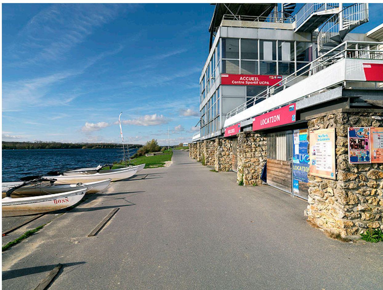
Le soubassement du bâtiment de l'UCPA.
