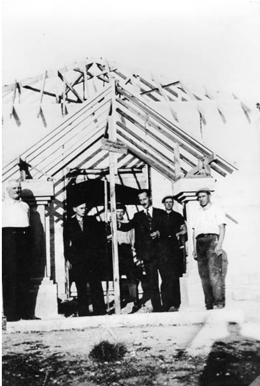
Photo ancienne. Construction de l'église orthodoxe en 1937-1938 sur les plans de J.Papandopoulos, ingénieur de la société PIC de Fontainebleau.
