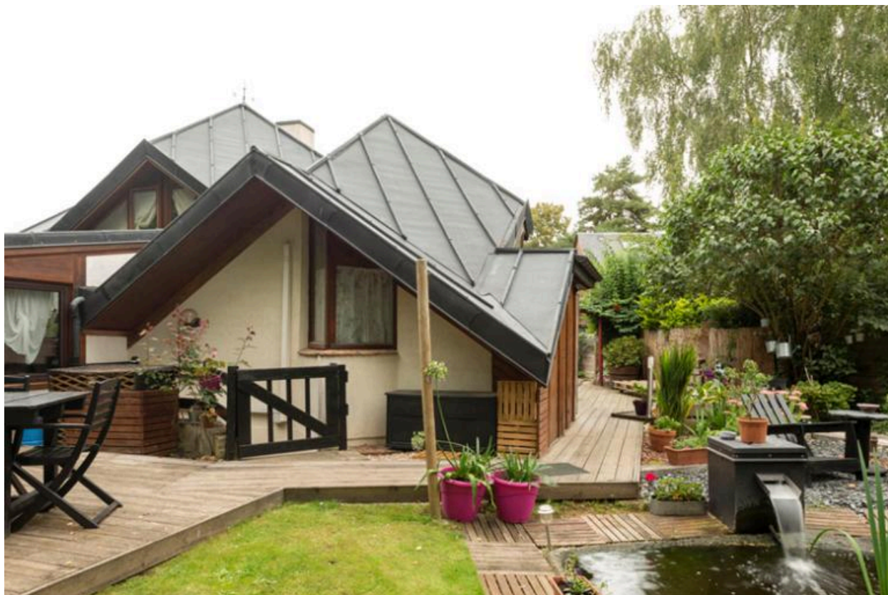
Vue rapprochée de la façade antérieure.
