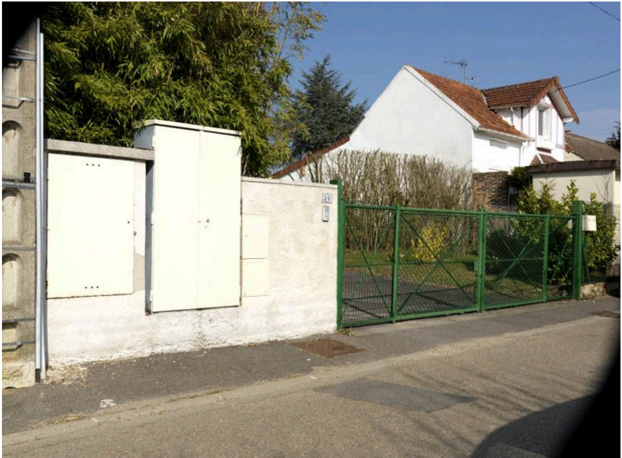
Entrée du site.
