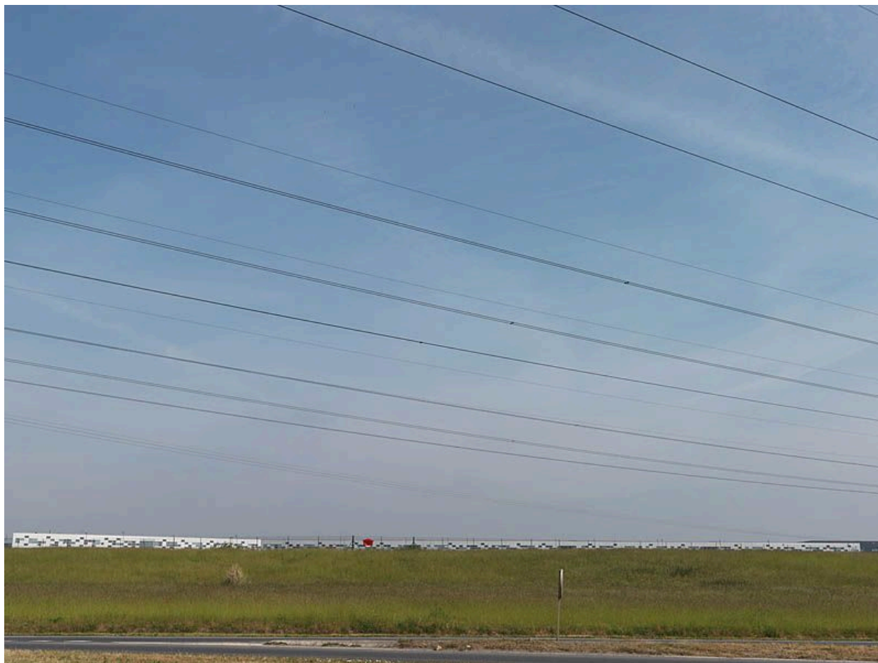
93, Tremblay-en-France, route de Roissy-en-France. Entrepôts de la plateforme aéroportuaire.
