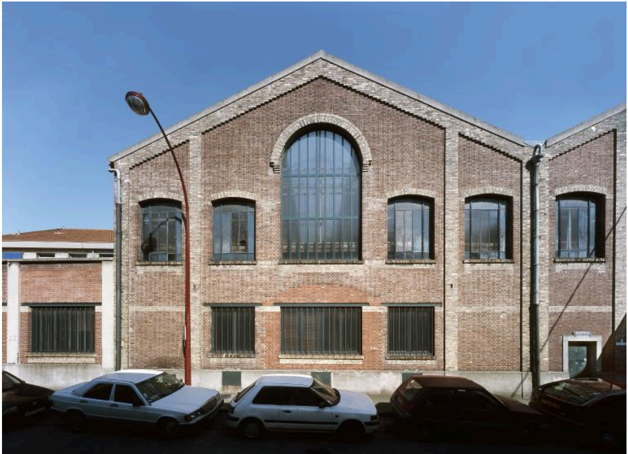
Pignon gauche de l'ancien atelier de chaudronnerie de l'usine Rateau (1917).
