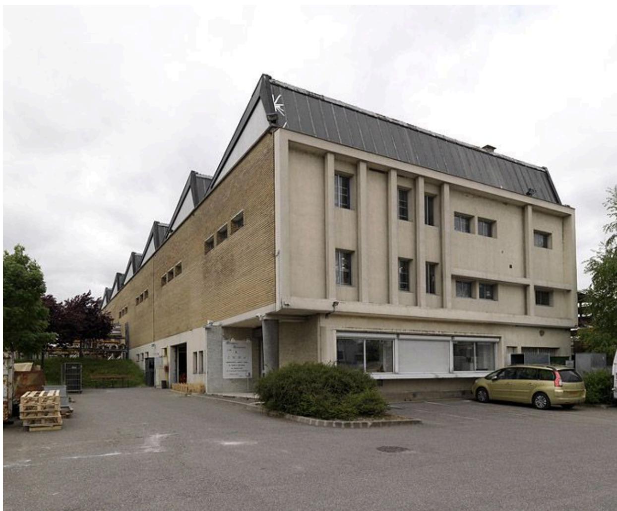
Vitry-sur-Seine, immeuble industriel, 37-39 rue Léon-Geoffroy. Vue d'ensemble.
