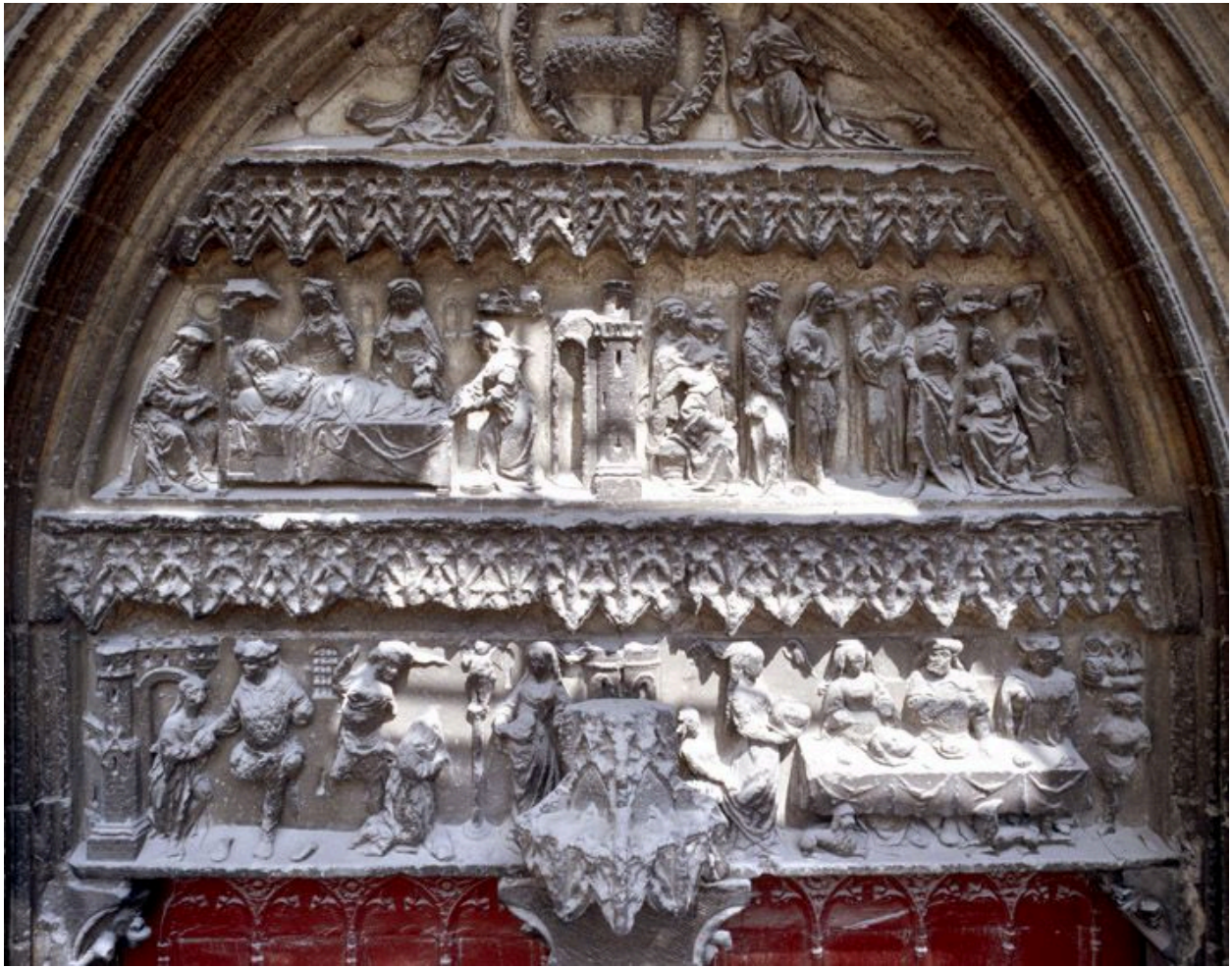
Les sculptures du portail Saint-Jean-Baptiste, vues depuis l'échafaudage dressé pour la restauration de la base de la tour nord (2008) : le tympan.
