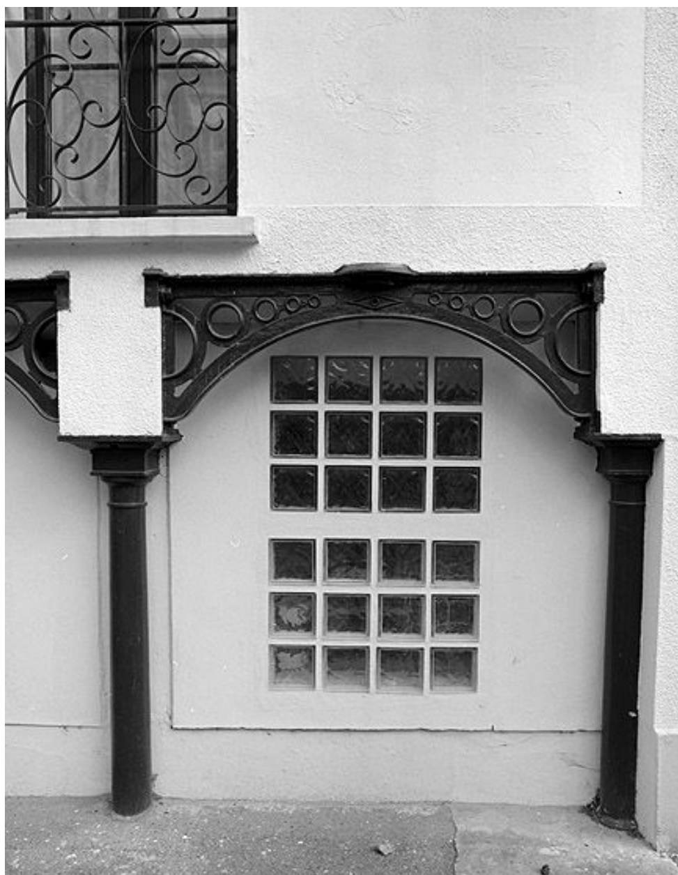
Détail des arcs en fonte de la façade.
