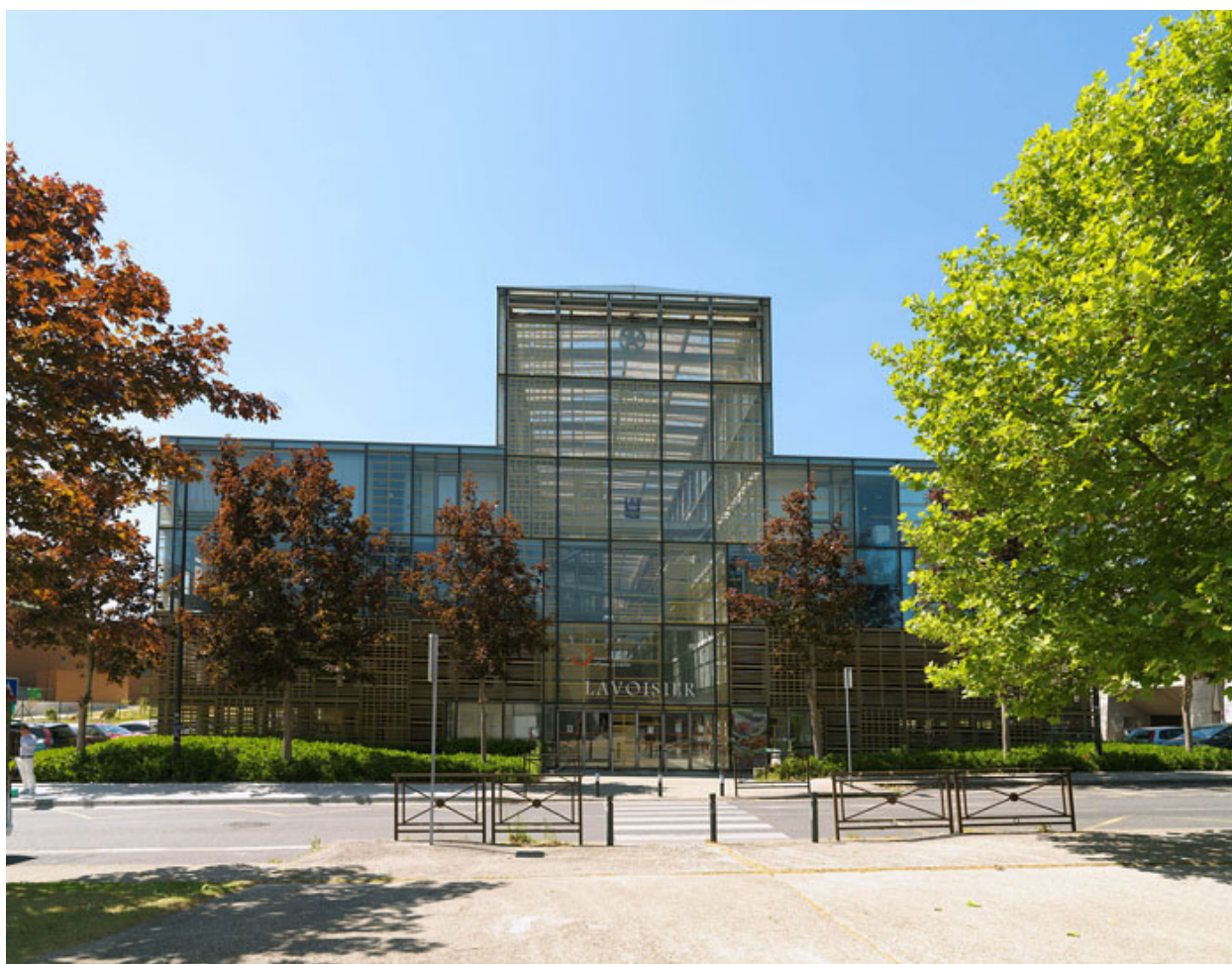
Bâtiment Antoine de Lavoisier, vue de l'entrée principale à l'ouest.
