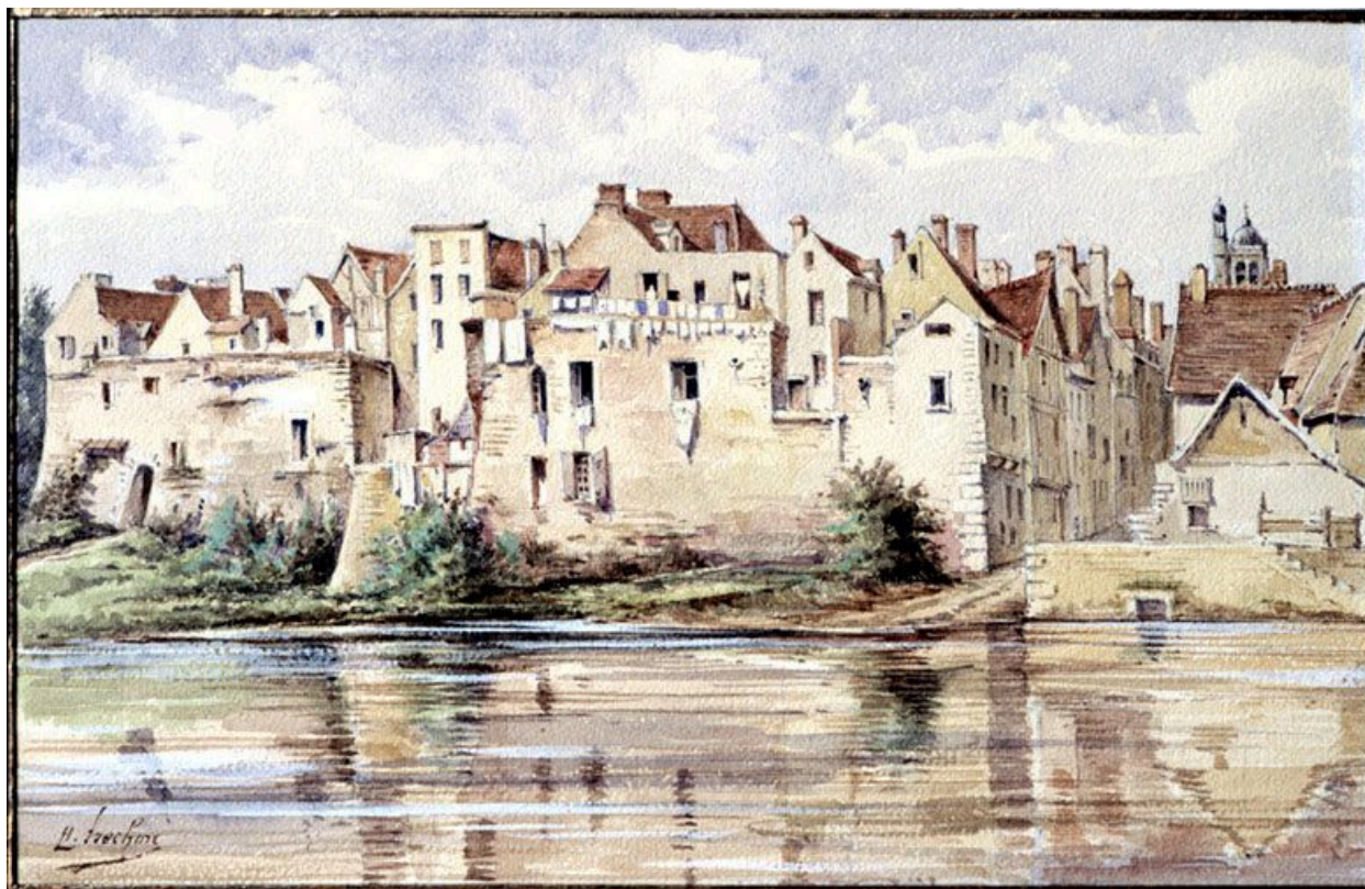
Le quai Pasteur avant sa reconstruction. Aquarelle de Fréchon, d'après un dessin de Decourbe. Dessin, 19e siècle. (Musée municipal de Melun)
