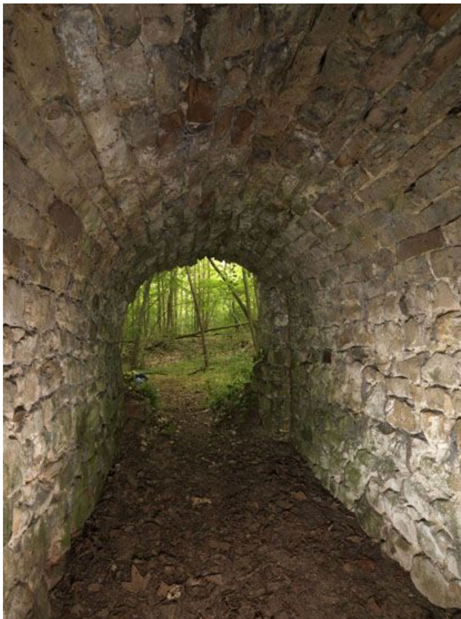
Le couloir de la glacière en direction de l'extérieur.
