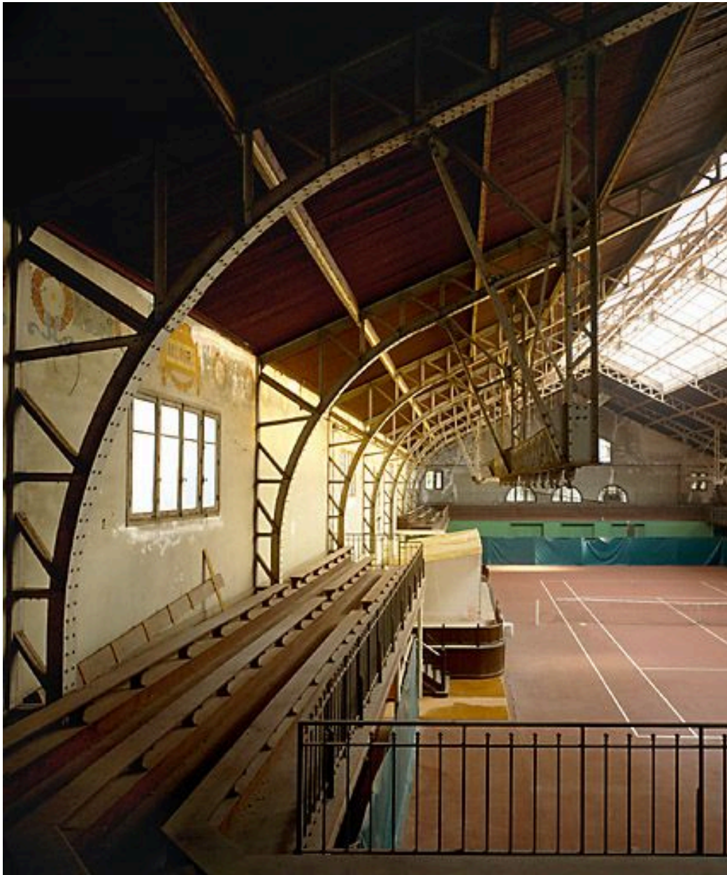
Salle de gymnastique (actuellement tennis couvert). Vue sur les tribunes, la charpente métallique et la poutre de suspension des crochets d'agrès.
