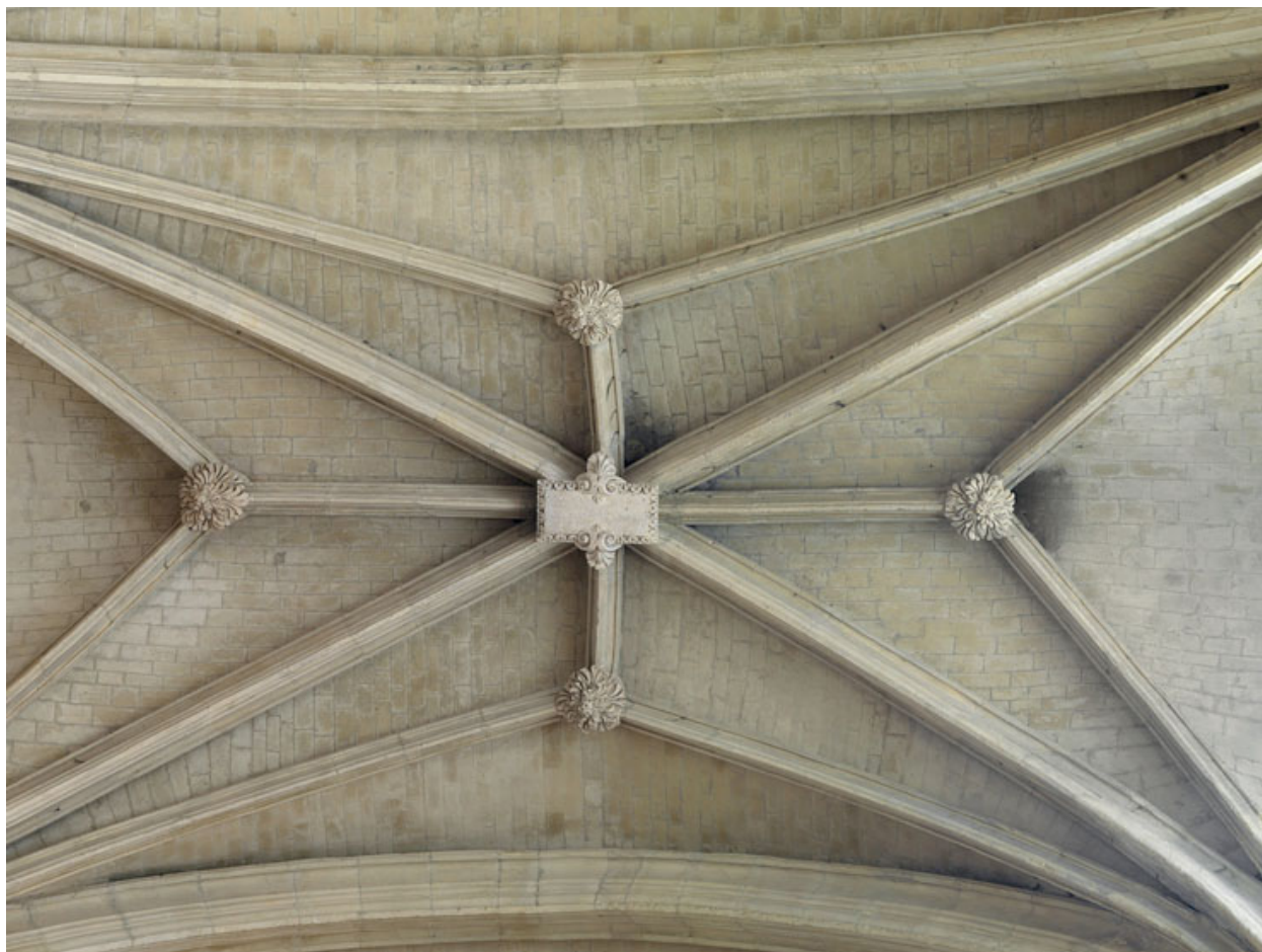
Voûte d'une travée droite du choeur.
