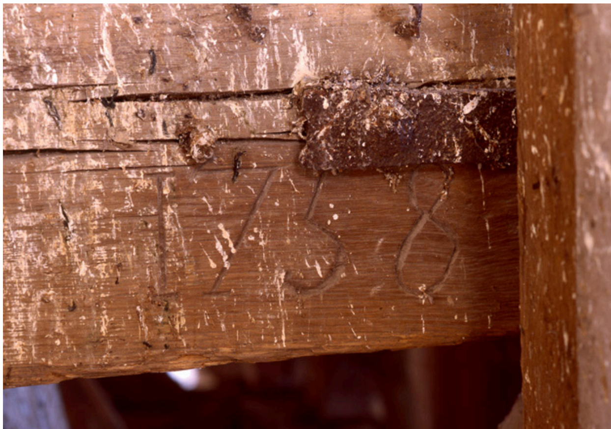
La charpente du clocher : détail de la date portée, "1738".
