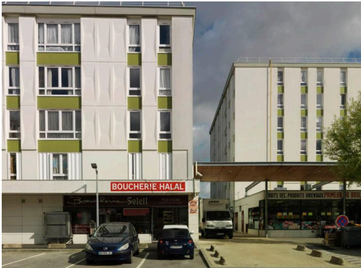
Boucherie halal en rez-de-chaussée de l'un des immeubles du secteur du Château, place du Marché.
