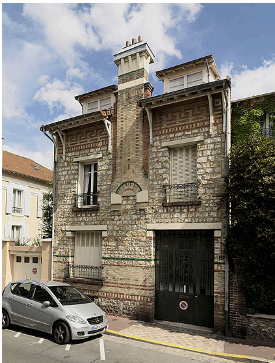
Vue de la façade de l'édifice avec ses décors de briques et sa porte cochère en ferronnerie.
