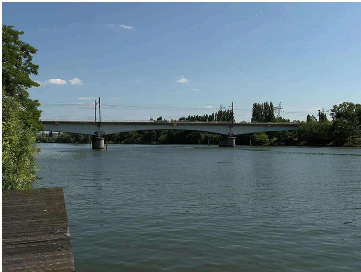
Choisy-le-Roi. Pont ferroviaire de la grande ceinture. Vue d'ensemble.
