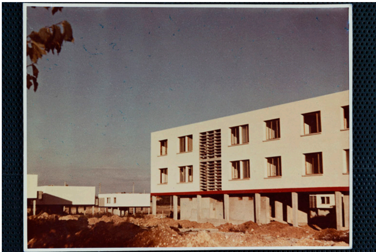
Vue partielle de la façade arrière d'un immeuble R+2 et 9 travées. (IFA Paris)
