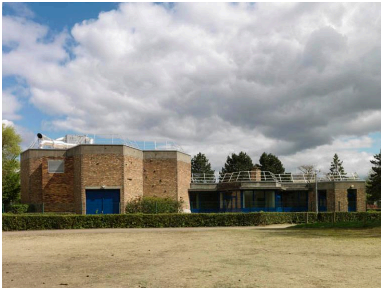
La structure alvéolaire de la Maison des Jeunes et de la Culture.
