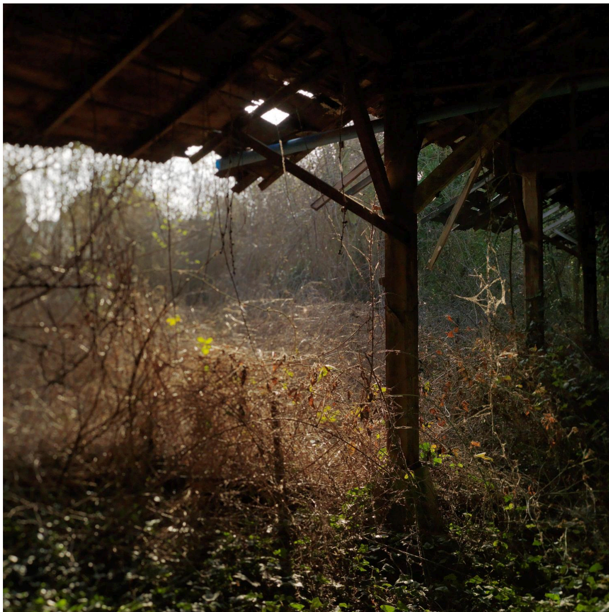
Hangar de production, structure à poteaux et charpente en bois.
