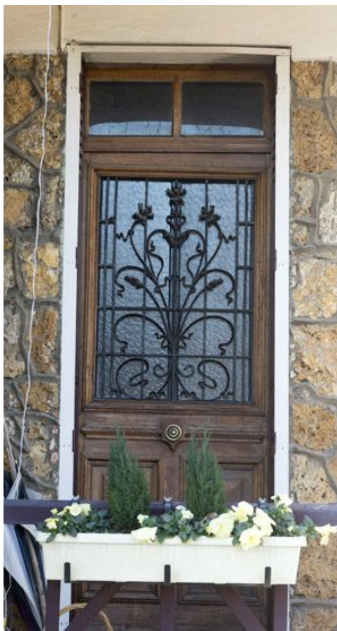
Maison, 7, avenue de la Marne. Détail de la porte d'entrée.
