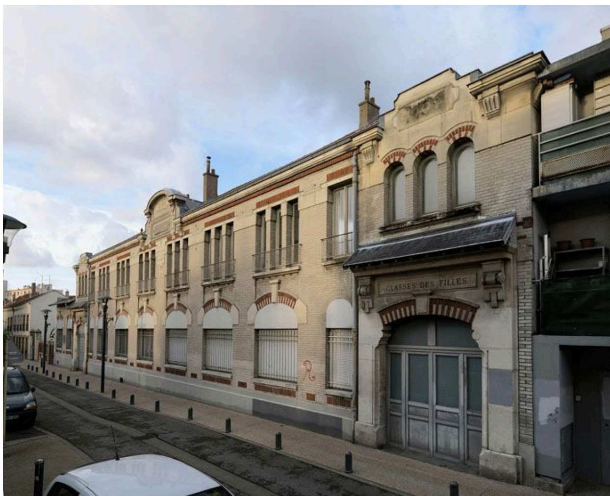
Ecole Abbé Houël, rue de l'Abbé Houël, réalisée en 1869 par Ernest Bertrand. Vue de la façade principale
