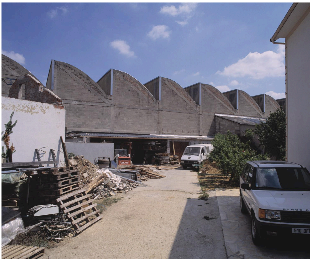
Les sheds du hangar vus de la rue Romain-Rolland.
