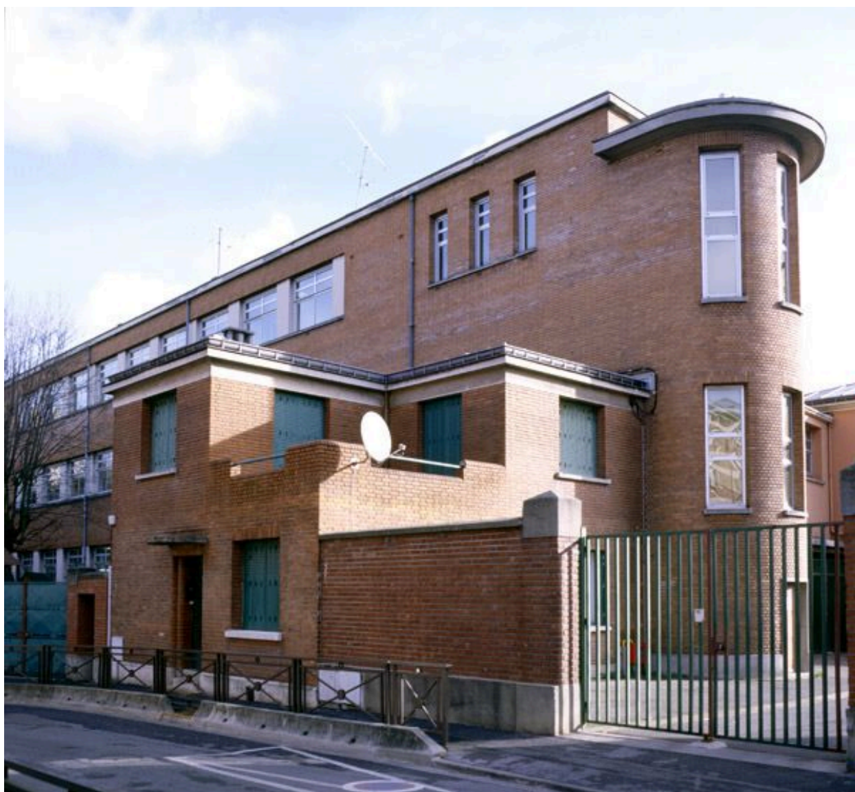
Vue du groupe scolaire Albert-Thomas, rue Charles-Fourier.
