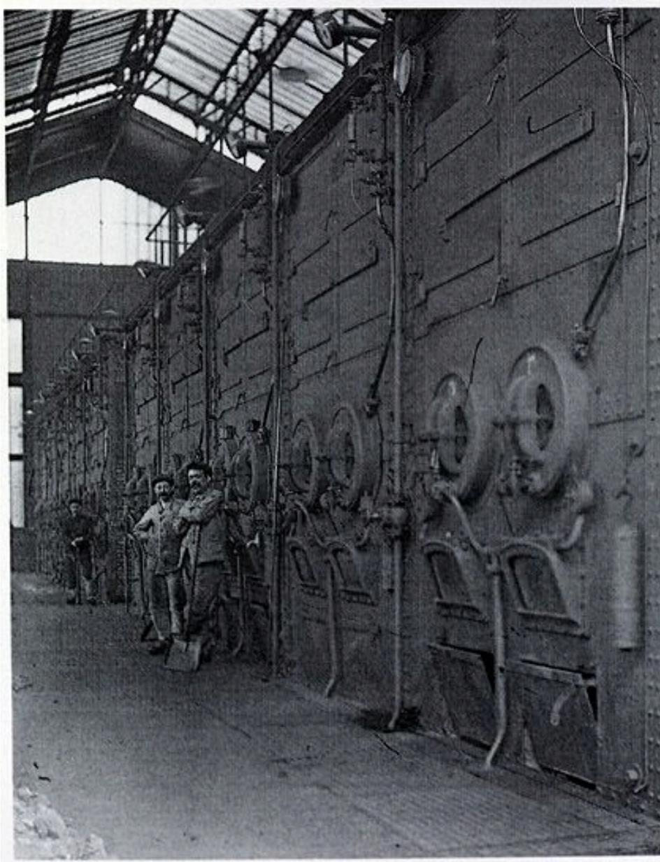
Ivry-sur-Seine, établissement élévateur des eaux dite compagnie des bassins filtrants de la ville de Paris. Les fours à charbon fournissant l'énergie aux pompes à vapeur. Tiré de : L'eau de Paris / M. Gaillard, C. Abron. Edit. Martelle, 1995, p.142 - 151.
