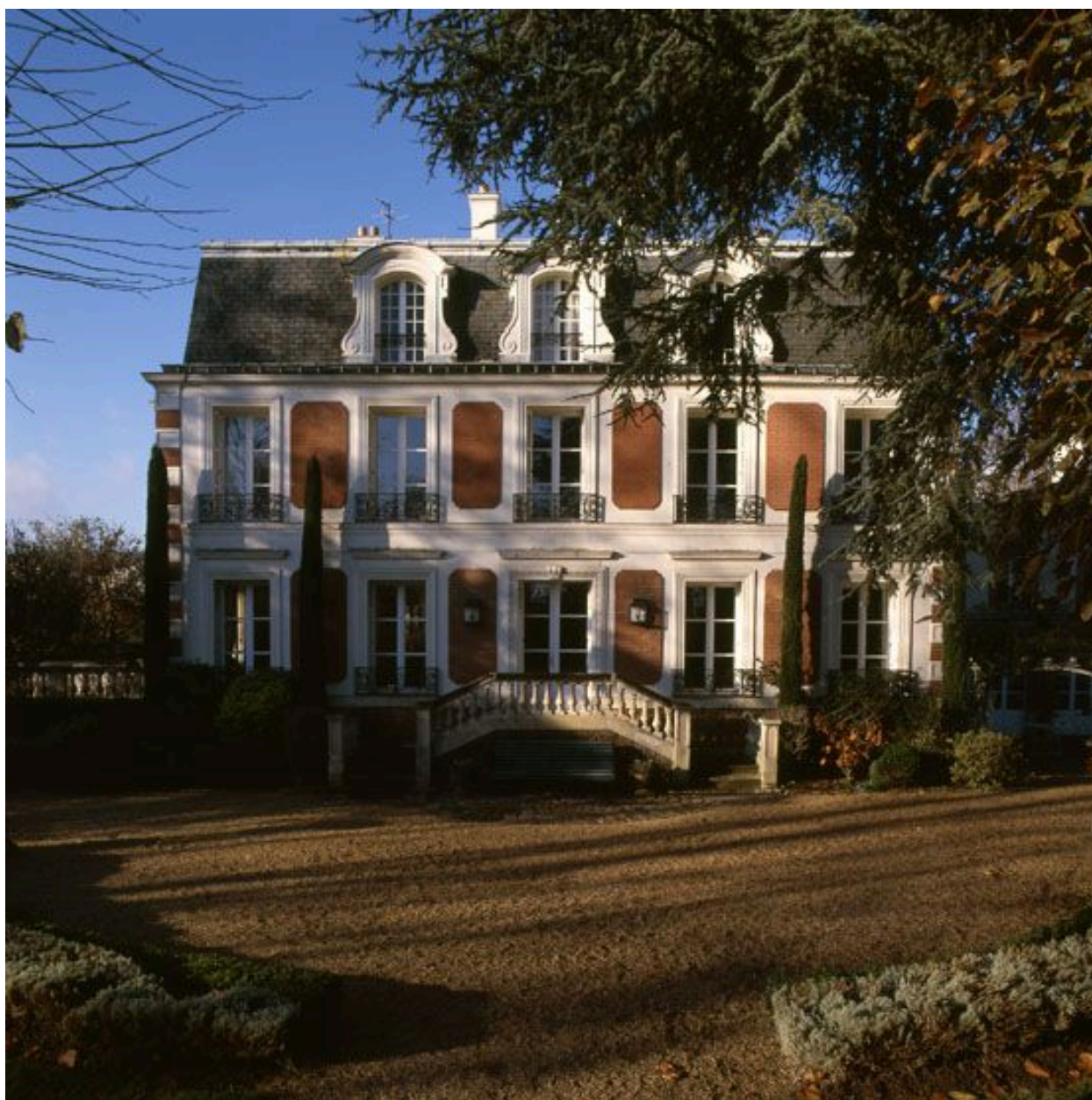
Vue d'ensemble de la façade antérieure sur jardin.
