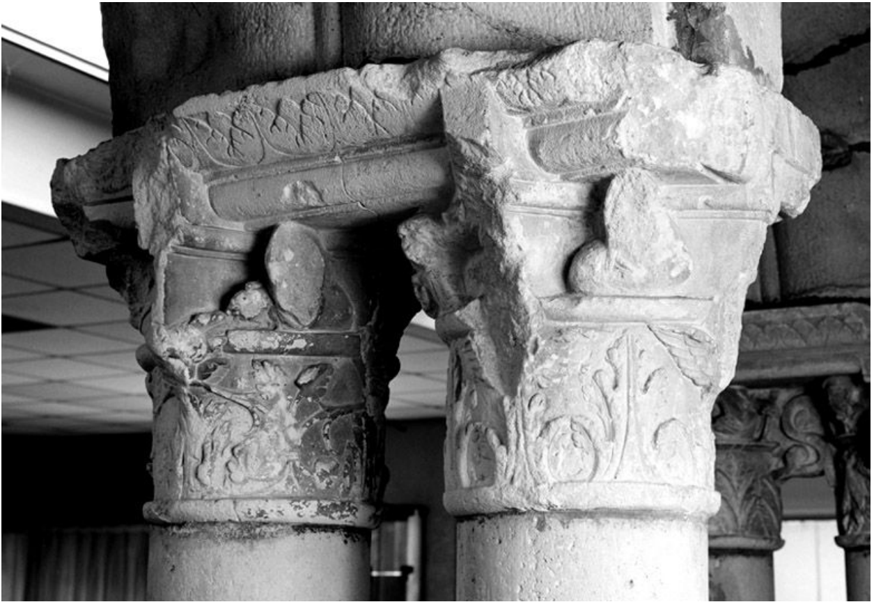
Chapiteaux sculptés de la 4eme paire de colonnes jumelées. Vue prise du nord-ouest.
