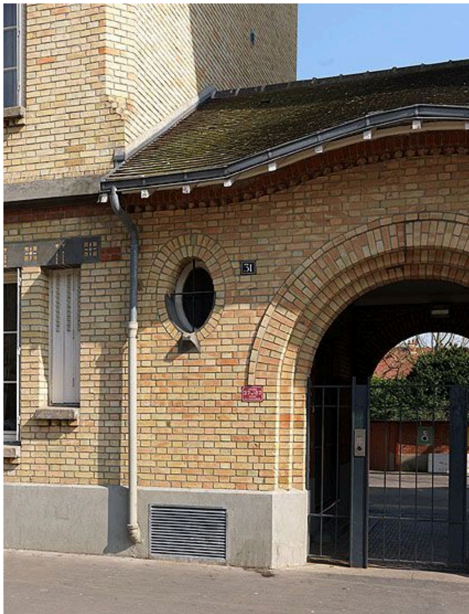
93, Stains, immeuble, 7 avenue de la Division-Leclerc . Porche d'accès à un jardin collectif d'un ensemble d'immeubles de l'avenue.
