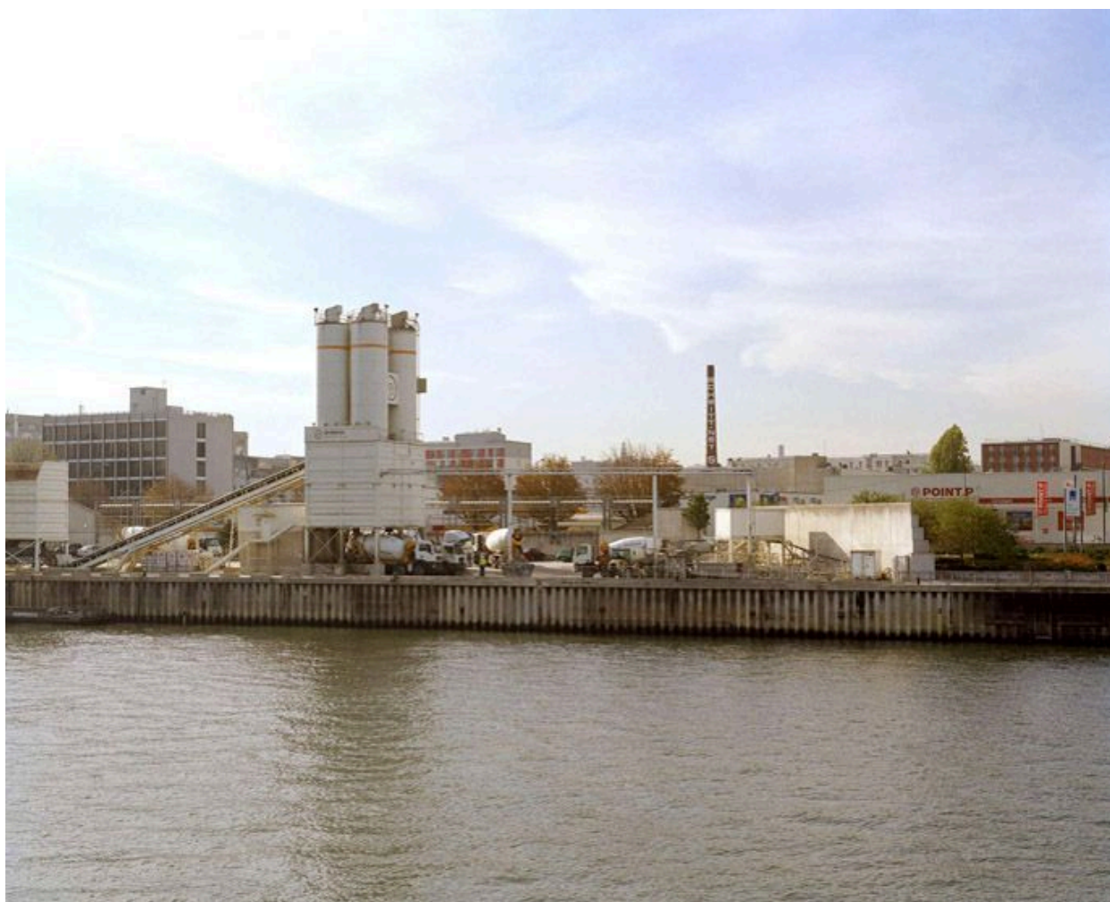
Ivry-sur-Seine. Vue rapprochée d'un quai de chargement.
