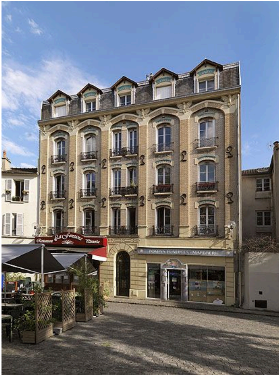
94, Gentilly, immeuble, 17 place Henri-Barbusse. Façade antérieure de l'immeuble.
