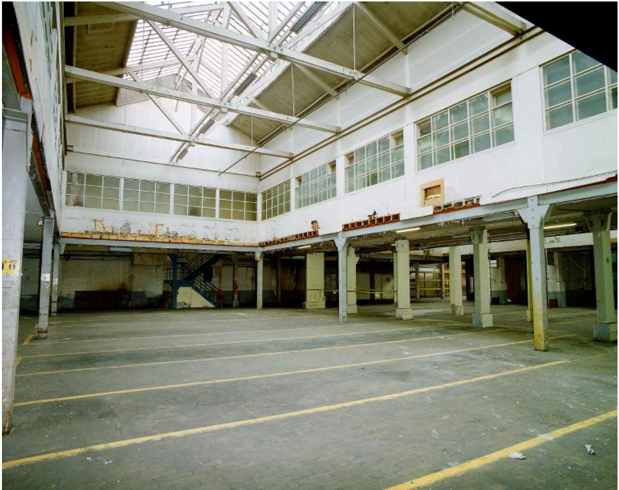
Intérieur de l'atelier de mécanique (N°2) de l'usine Rateau, élevé en 1916.
