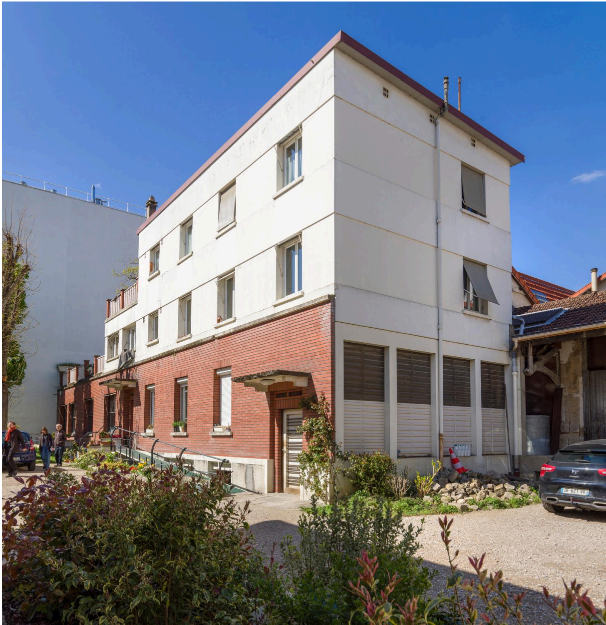
Vue extérieure des Ateliers de Technochimie, depuis la cour. Les bureaux et le pavillon d'habitation.
