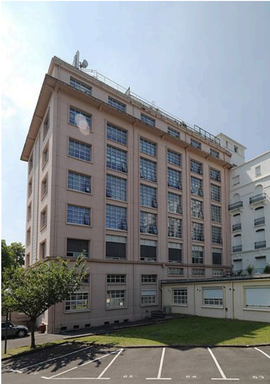
Vue de l'extension PIC depuis le sud-est.
