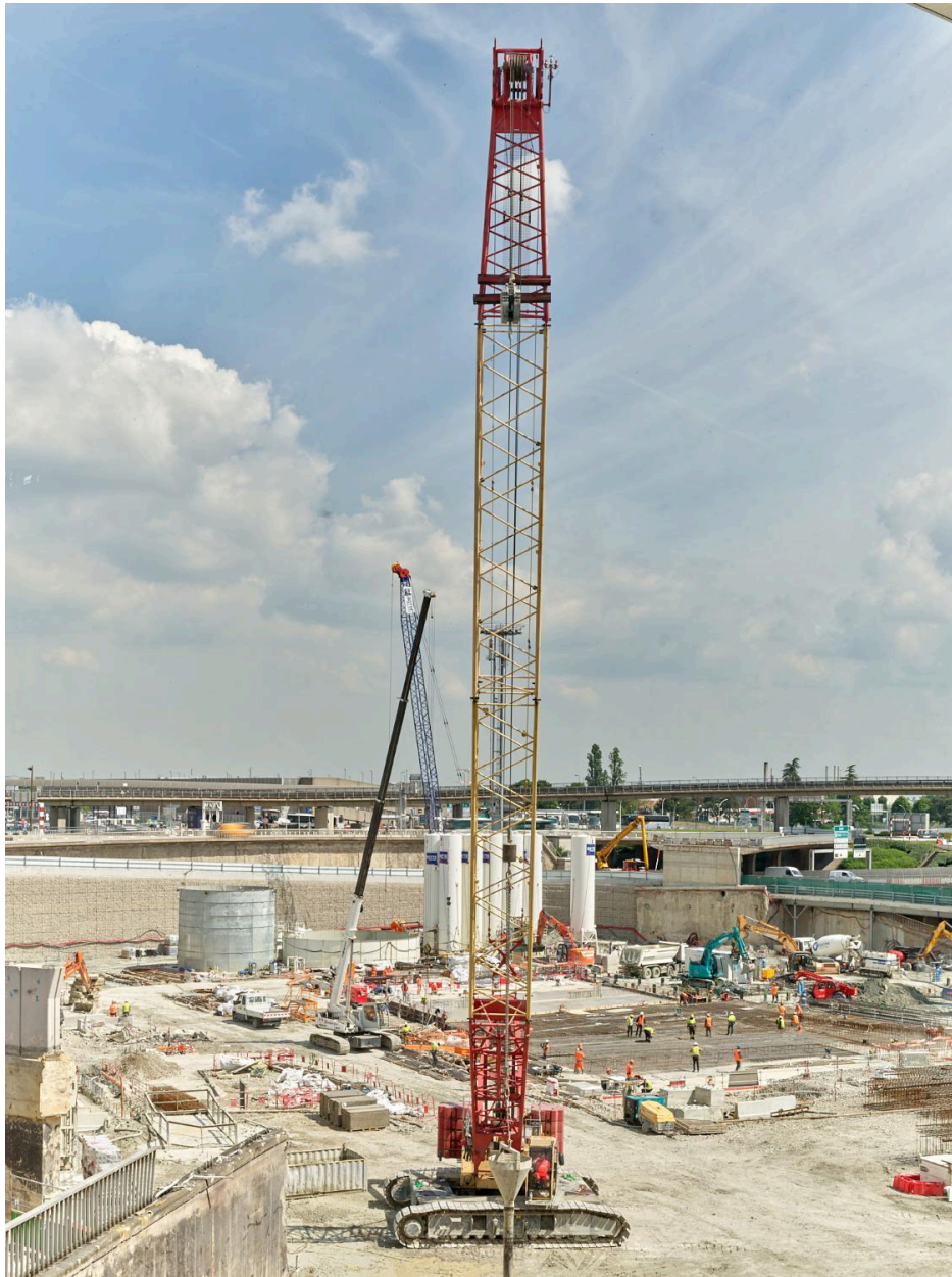
2018, chantier de construction de la station de métro Aéroport d'Orly (lignes 14 et 18) vu depuis le sud ouest.
