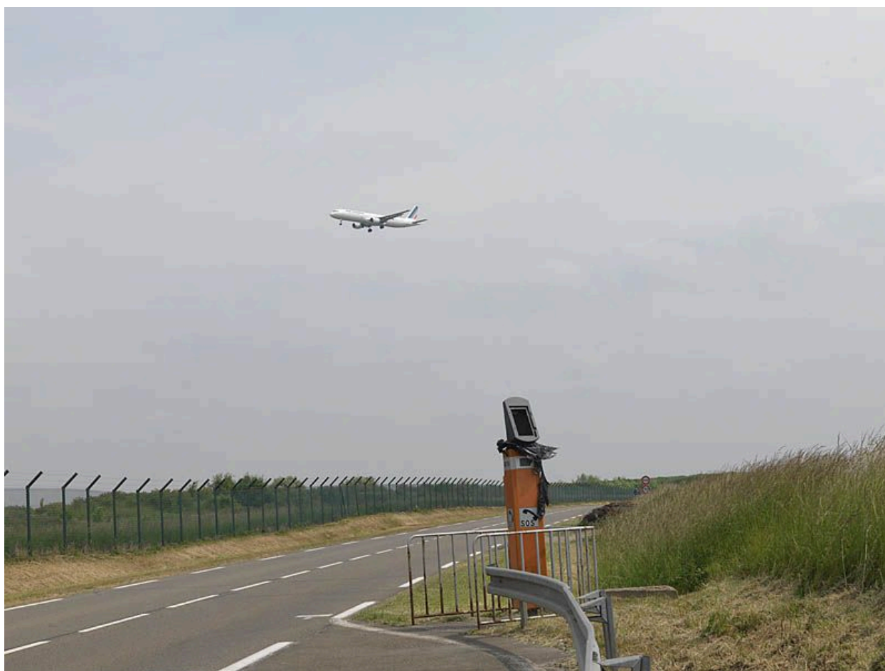
77, Mitry-Mory. Vue de la route périphérique sud de l'aéroport Charles de Gaulle au lieu-dit la Vallée les Grandes Vignes.
