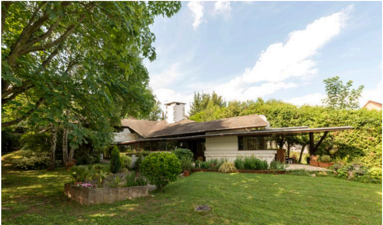
Vue de la façade principale côté jardin.
