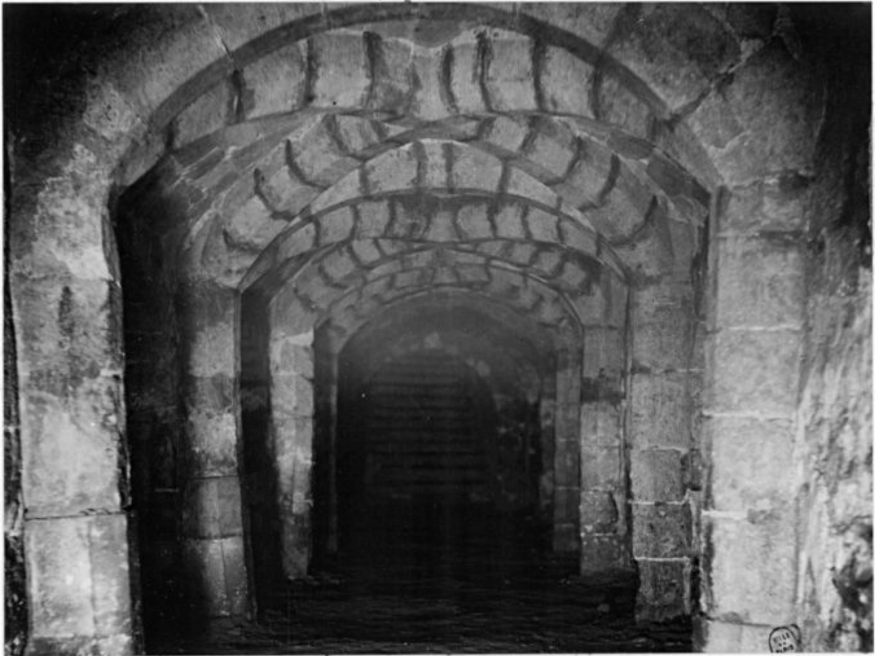
Cave du restaurant Aux caveaux du vieux monastère, 75 rue Louis-Talamoni. Photographie ancienne. Tiré de : Commission du Vieux Paris, 1904. (Musée d'Ile-de-France, Sceaux)
