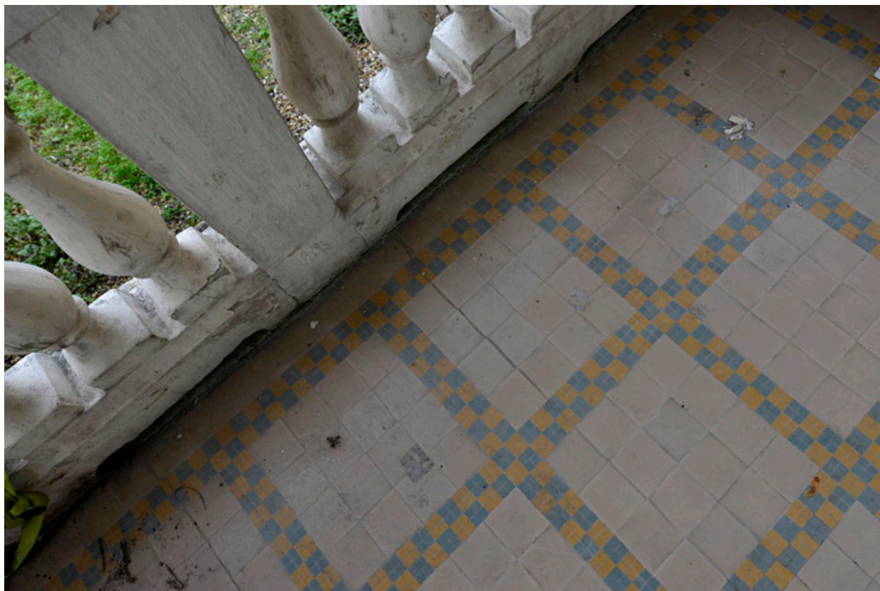
Carrelage extérieur de la maison de notable "les Chênes", 13 avenue du Maréchal-Joffre. Architectes: Sée et Chorein
