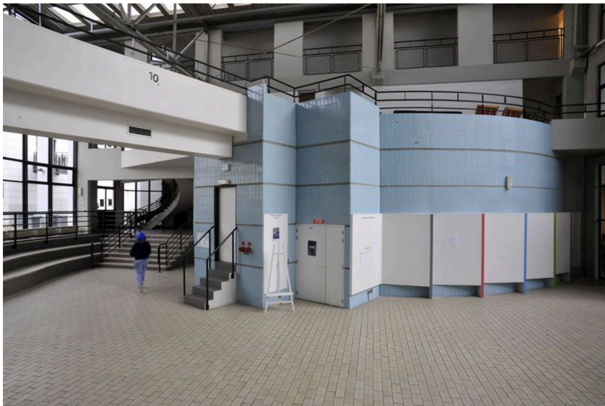
Vue d'ensemble du hall d'entrée de l'édifice.
