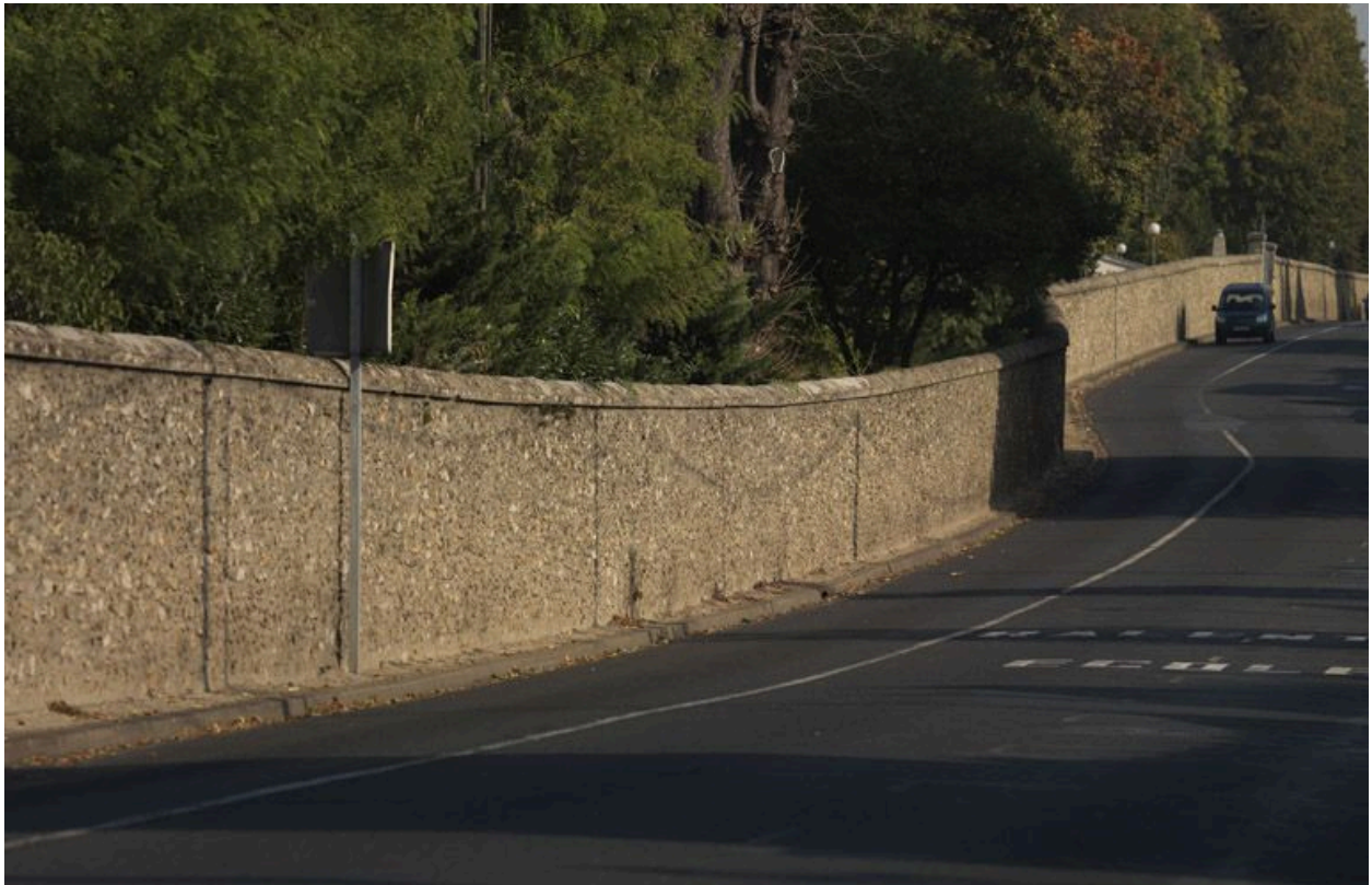
Le mur de clôture longeant l'avenue du général-de-Gaulle.
