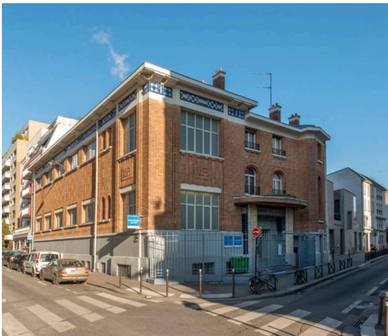
Vue générale des bains-douches de la rue des Haies.
