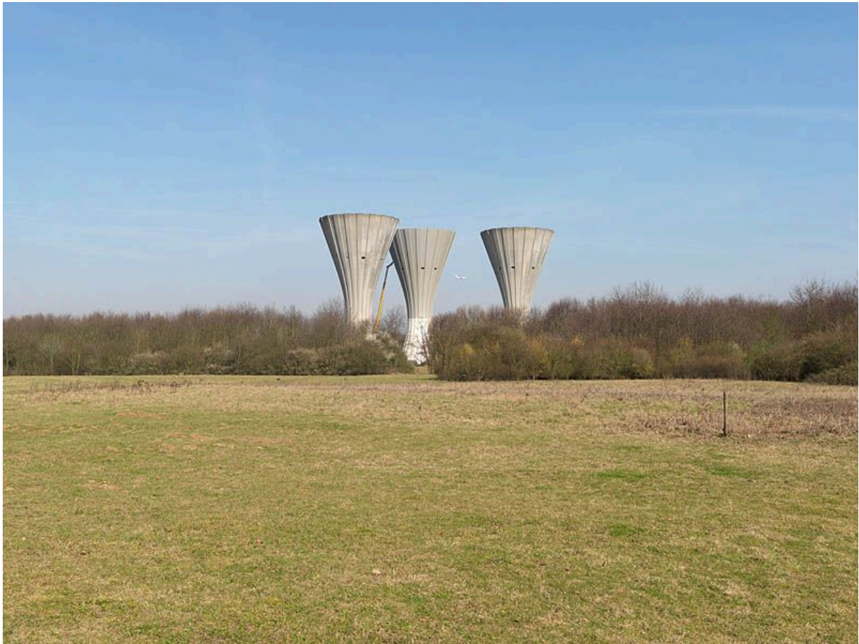
93, Tremblay-en-France, Parc départemental du Sausset. Les trois châteaux d'eau du parc.
