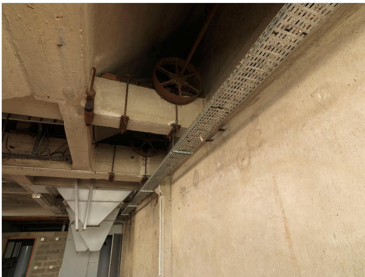
Site Biocitech. Vue intérieure des bâtiments désaffectés. Détail d'installation.
