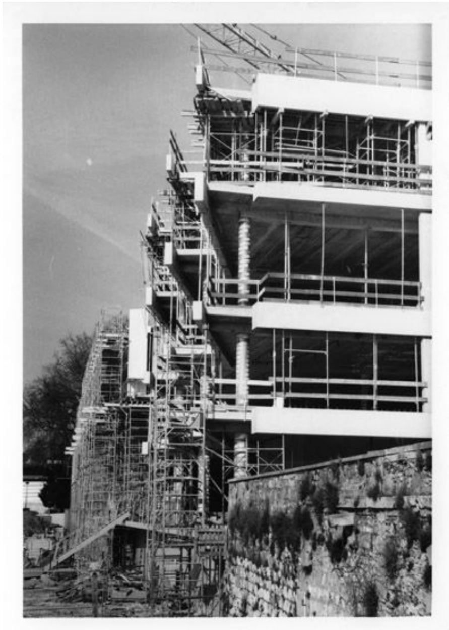
La médiathèque en cours de construction, 25 février 2002. (Collection particulière)
