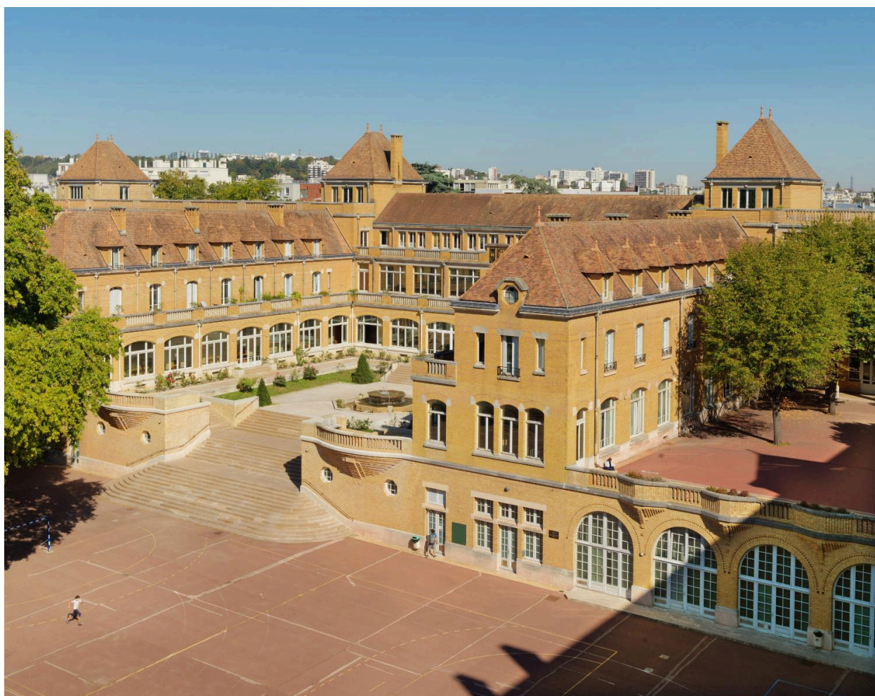
Vue générale du lycée.
