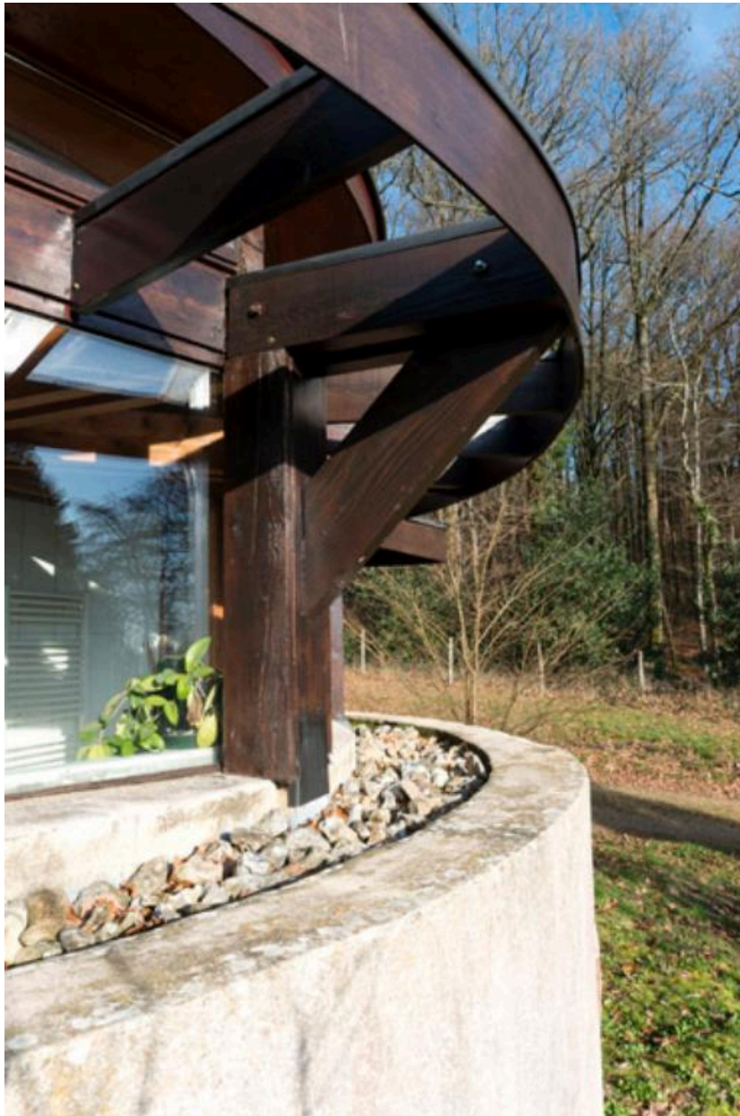
Détail d'une fenêtre (côté droit).
